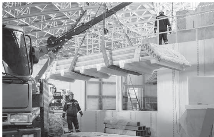
Монтаж хатча на площадке СКИФ
