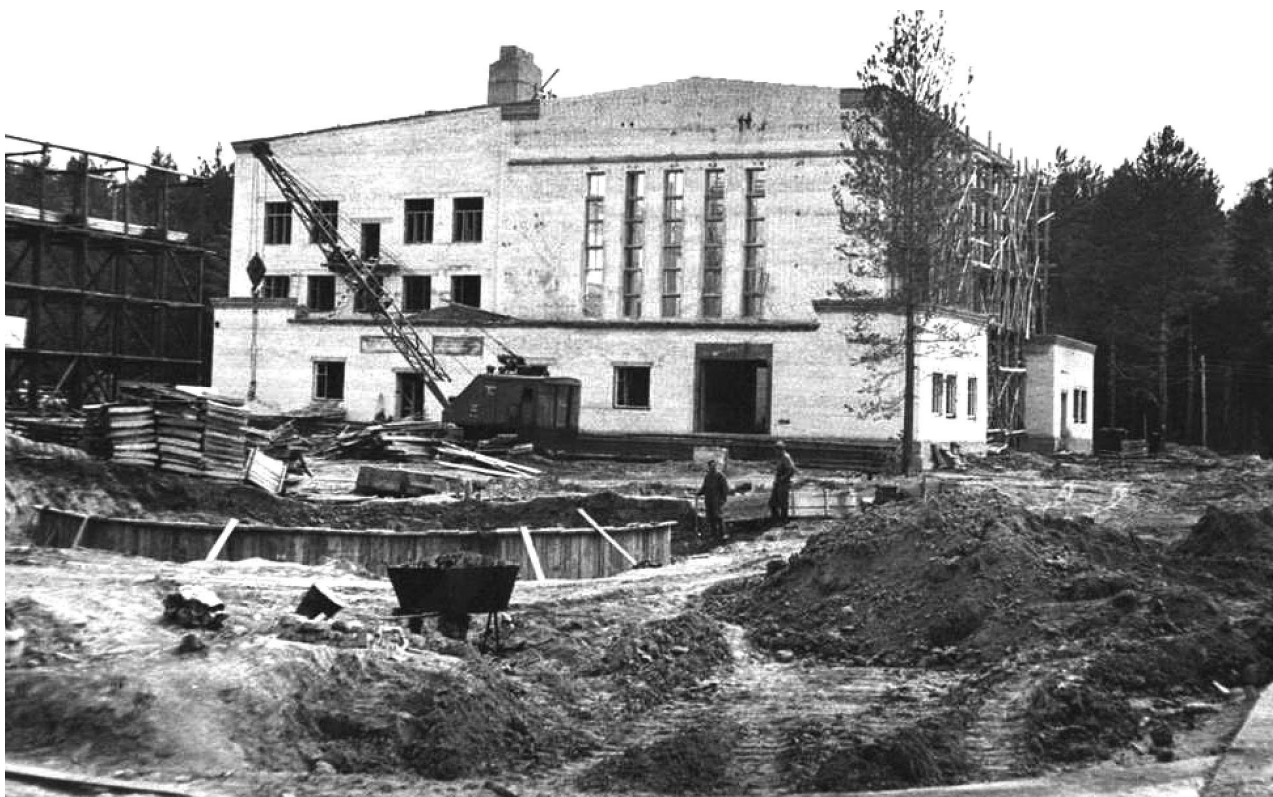
Строительство реактора, 1961 год.
