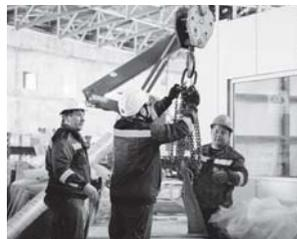
Команда инженеров ТПУ начала монтировать свинцовые ограничительные конструкции, которые обеспечат радиационную безопасность пользователей экспериментальных станций строящегося под Новосибирском Центра коллективного пользования «Сибирский кольцевой источник фотонов» (СКИФ). Также политехники монтируют инженерные сети, необходимые для функционирования станции. Монтаж первых свинцовых «боксов» завершен в конце мая – помещение готово к установке в нем научного оборудования.
