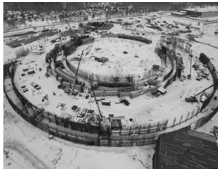
Строительство накопителя СКИФ, март 2024 г. Источник: ЦКП «СКИФ»
