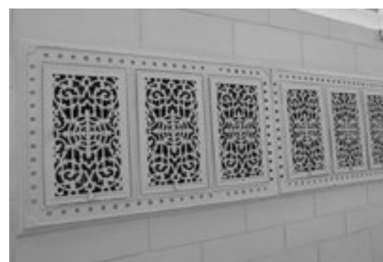
Декоративная решетка труб отопления в главном корпусе ТПУ
