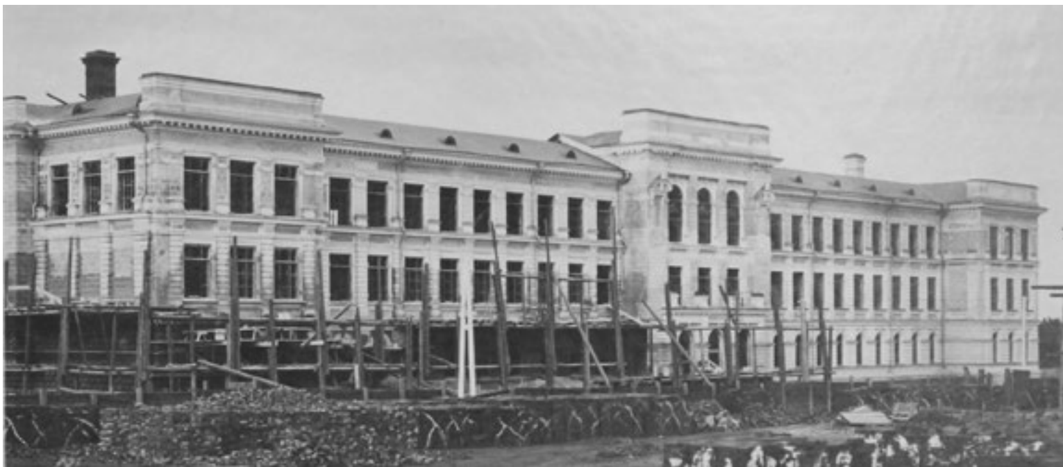
Сентябрь 1900 года, институт еще в строительных лесах
